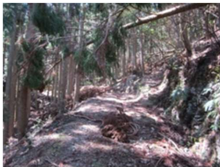
＜修繕前の作業道＞
