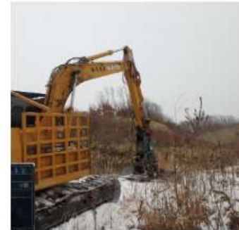
作業道補修中
