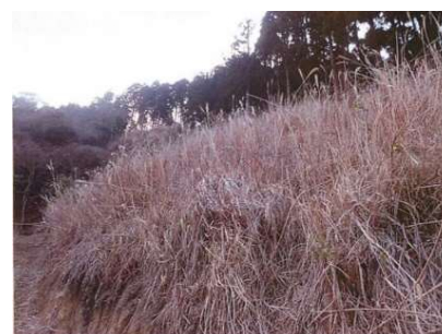
＜保護柵の設置前＞
