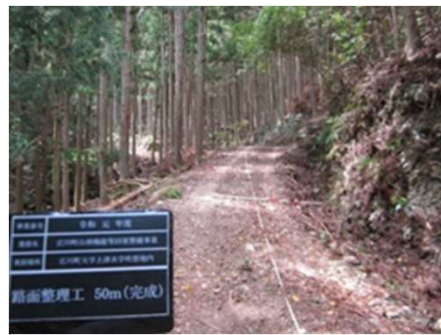
＜修繕後の作業道＞
