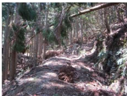
（事業1：作業道修繕前）
