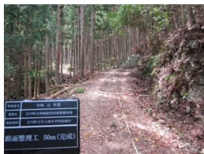
（事業1：作業道修繕後）
